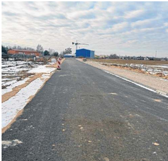
105 zadań rozbudowy dróg, w tym 88 gminnych i 17 powiatowych zostanie w całości w tym roku sfinansowanych w ramach Rządowego Funduszu Rozwoju Dróg
