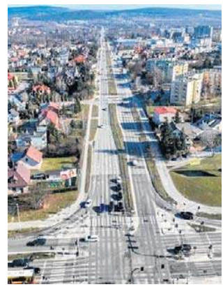
Część ulicy Warszawskiej pójdzie do remontu
