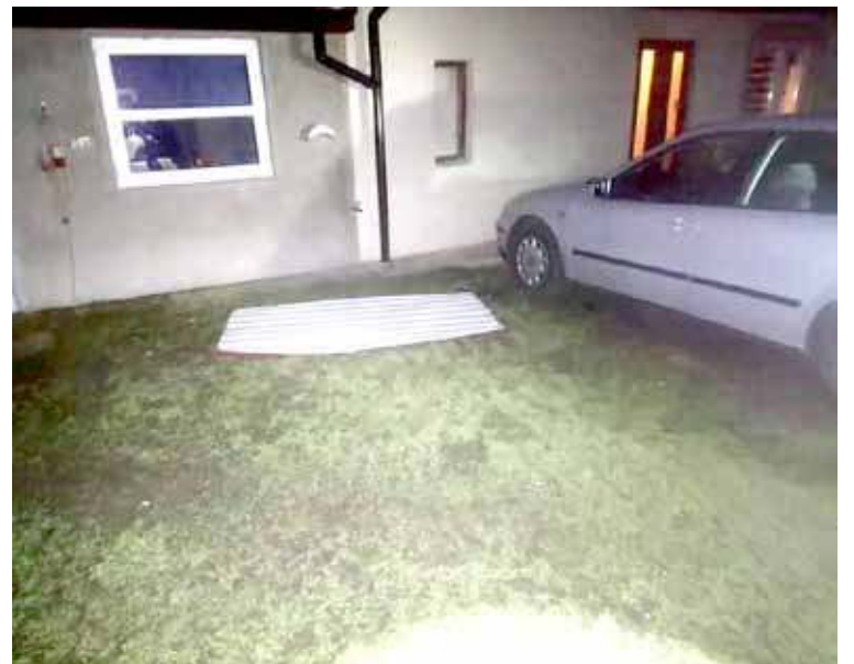
Na ulicy Stargardzkiej wichura uszkodziła dachy na budynkach. Foto. OSP. Marianowo
