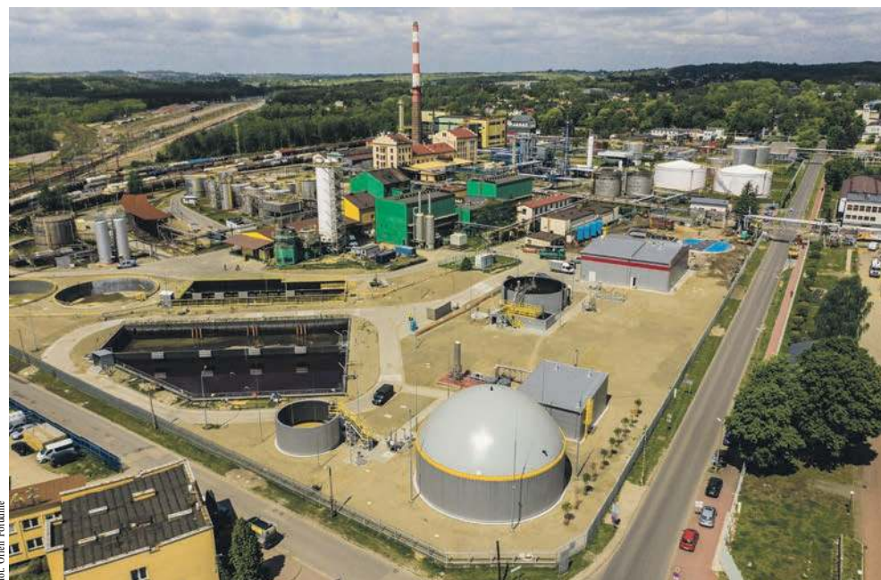
Pierwsze metry sześciennego oczyszczonego ścieku trafiły do odbiornika powierzchniowego latem tego roku
