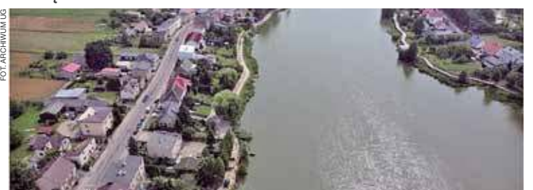
Aktualny stan inwestycji z lotu ptaka
