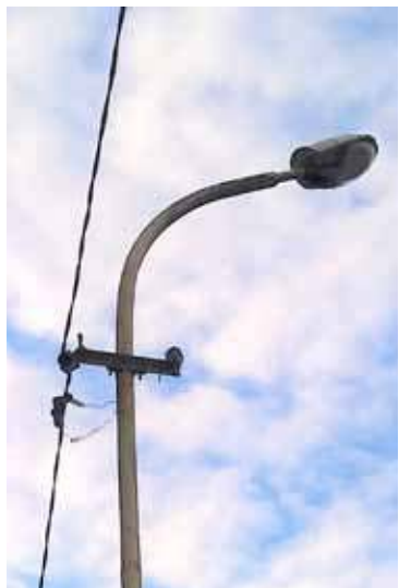
Przy ul. Broniewskiego wymienionych zostanie aż 86 lamp ulicznych. Nowe latarnie będą posiadały oprawy LED
