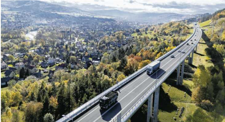
• Otwarto odcinek trasy S1 Przybędza - Milówka, zwany obejściem Węgierskiej Górki. Na tę drogę czekali mieszkańcy i turyści
