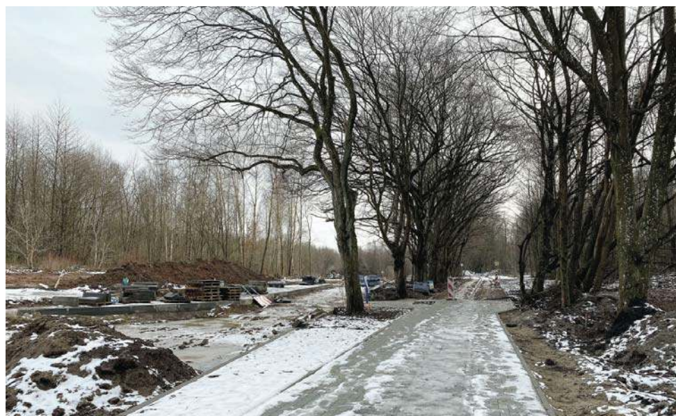
Drugi etap budowy ul. Wschodniej został odłożony w czasie
