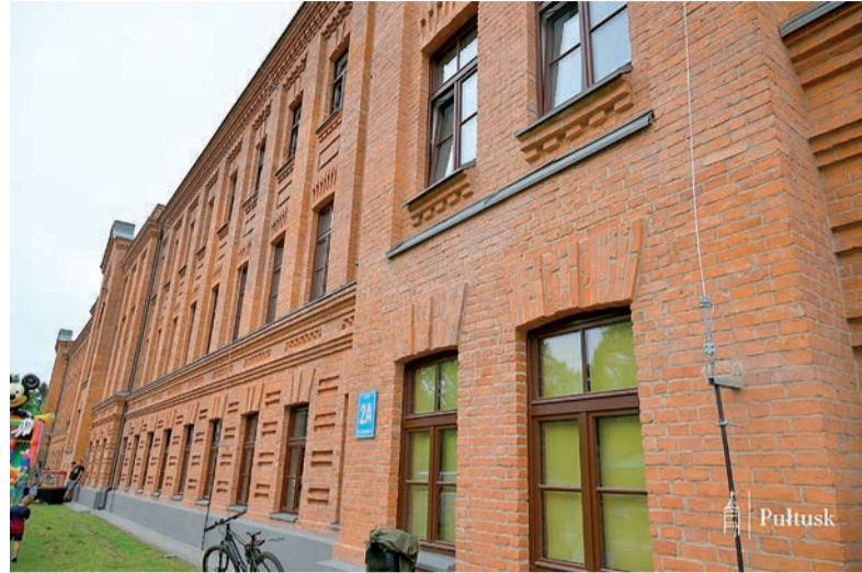
Zrewitalizowany budynek mieszkalny jest teraz bezpiecznym domem dla 63 rodzin
