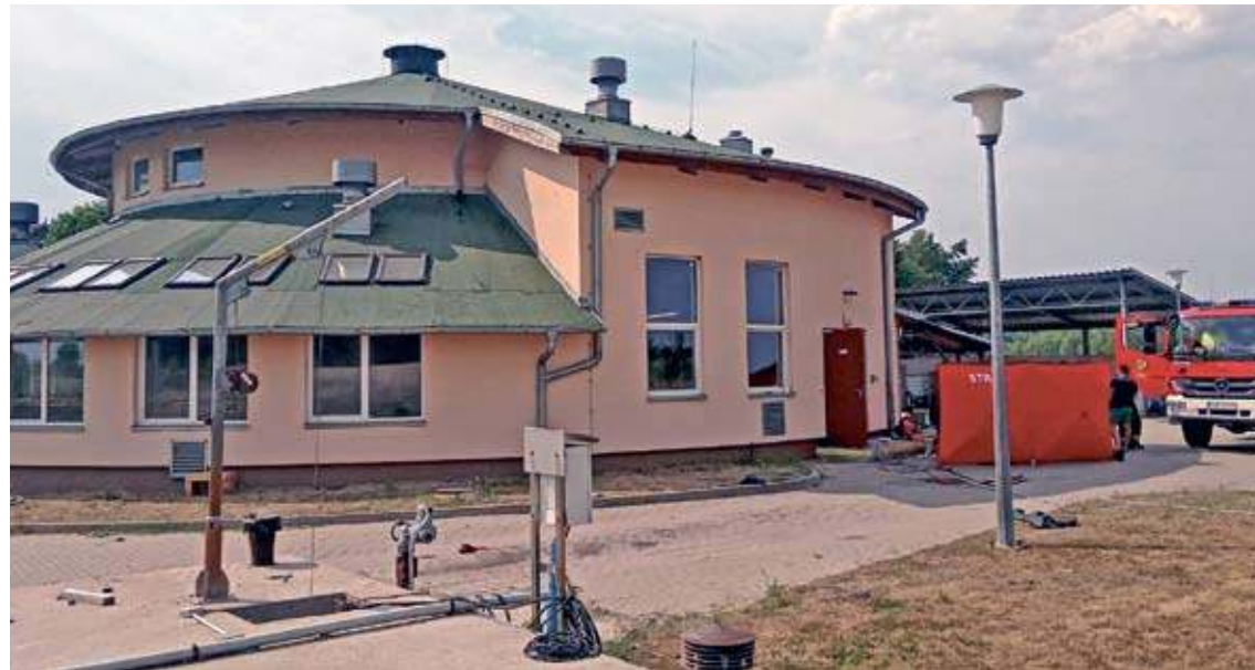
Od momentu tej wielkiej tragedii oczyszczalnia jest zamknięta (fot. arch.)
