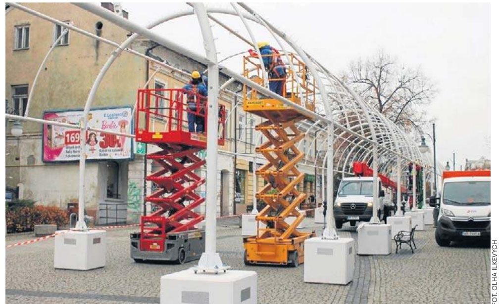
Na deptaku w Radomiu trwa montaż tunelu świetlnego. Będzie miał ponad 100 metrów. Konstrukcję, jak co roku, ustawiają pracownicy Zakładu Usług Komunalnych.
