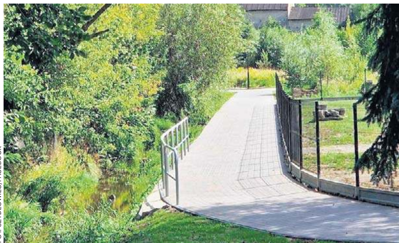
Zakończyła się budowa nowego odcinka deptaka nad Korzeniówką w Szydłowcu.
