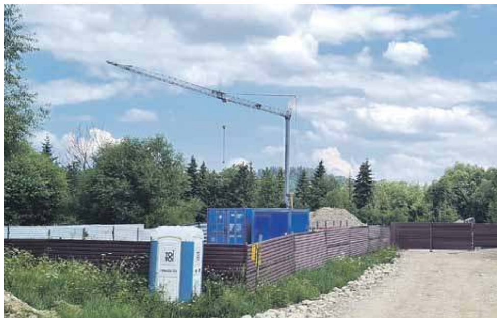
Widać już postępy budowy na Grapie. Oczyszczalnia będzie gotowa pod koniec przyszłego roku.
