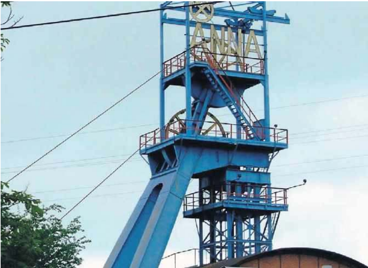
Kopalni Węgla Kamiennego „Anna” już nie ma. FOT. MAT.PRASOWY
