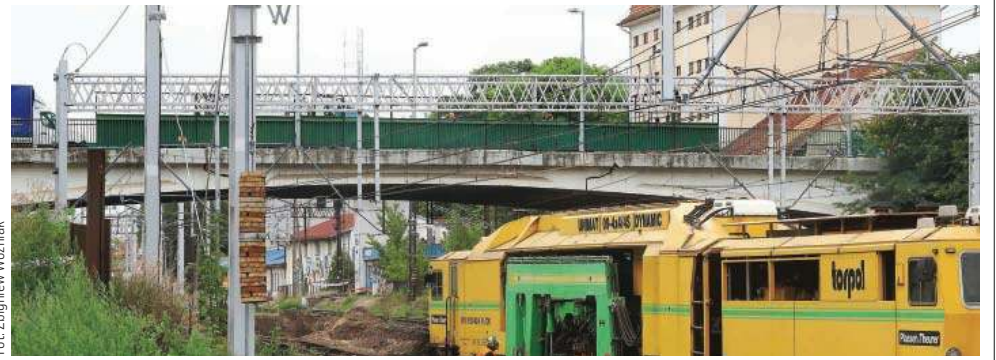
Wiadukt im. Powstańców Węgierskich ma już 70 lat
