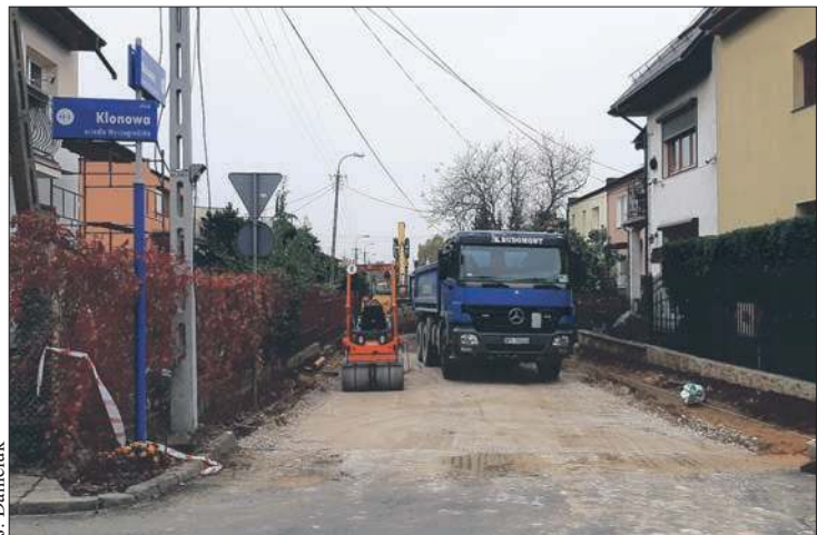
Trwa przebudowa ulicy Bukowej
