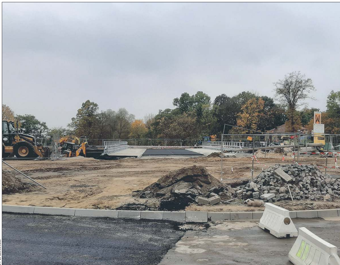
W ubiegłym tygodniu na wiadukcie, który powstaje nad torami kolejowymi w sąsiedztwie ogrodu zoologicznego był wylewany asfalt
