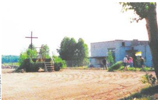
Miejsce budowy kościoła parafialnego pw. św. Faustyny w Jamielniku
