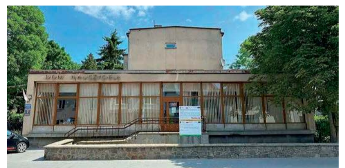
Budynek przejdzie metamorfozę
