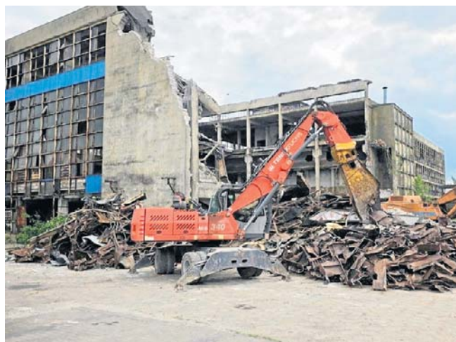
Wyburzanie budynków dawnej Huty Szkła Okiennego Kara w Piotrkowie Trybunalskim
