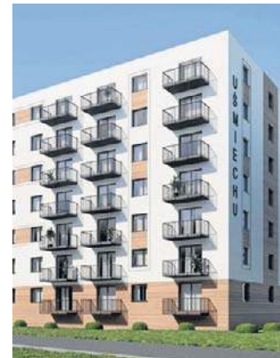
Przy ulicy Dożynkowej i Uśmiechu rusza budowa
