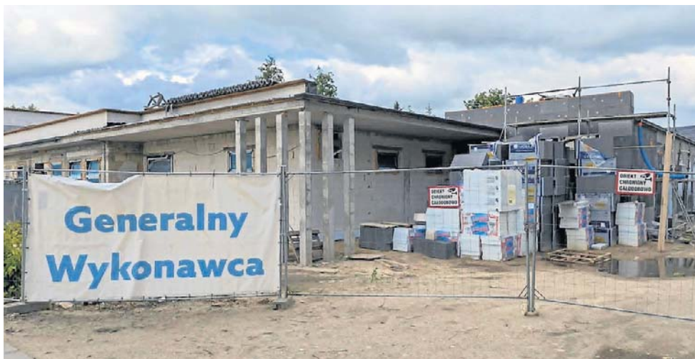
Obecnie na placu budowy przy ul. Jesionowej w Lichnowach nic się nie dzieje
