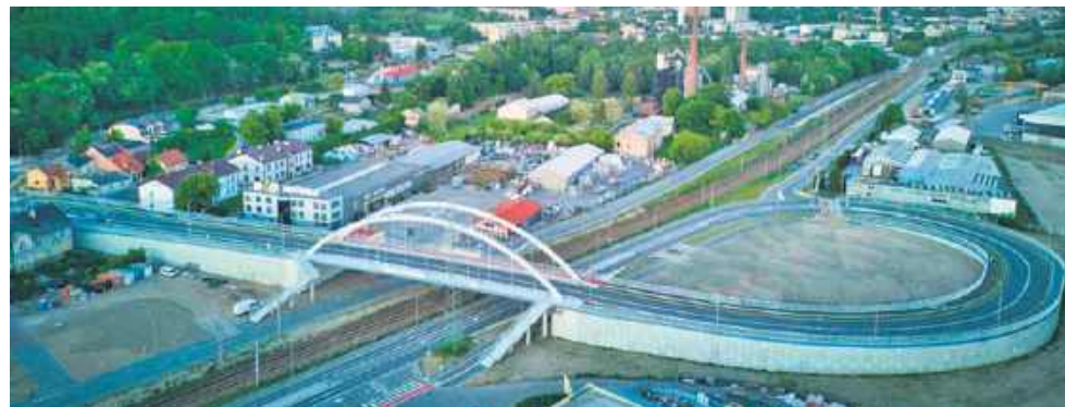
Jedno z najważniejszych przedsięwzięć - zakończenie budowy wiaduktu nad linią kolejową nr 25
