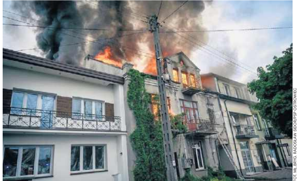
Pożar kamienicy przy ulicy Sandomierskiej w Ostrowcu świętokrzyskim. Ogień z kamienicy przeniósł się na inne budynki.
