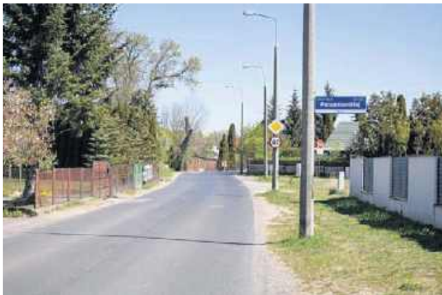
Ulica Stefanii Perzanowskiej w Radomiu będzie przebudowana na odcinku od ulicy Mieszka I.
