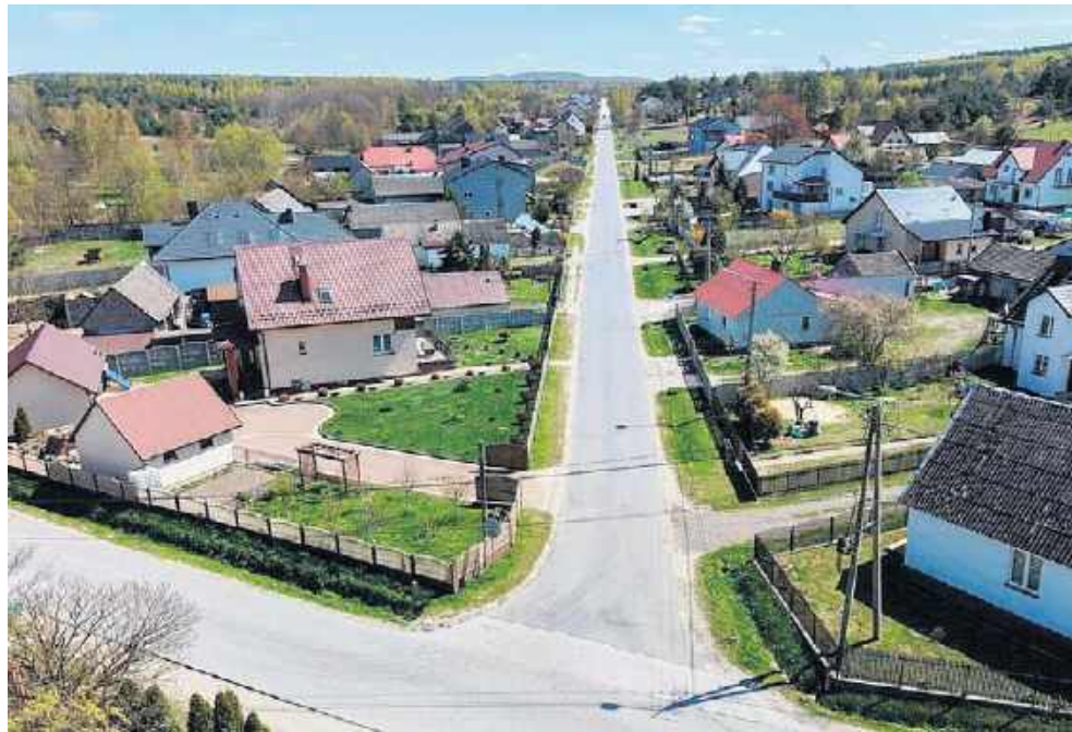
Obecnie droga znajduje się w złym stanie technicznym – nawierzchnia jest spękana, a ruch pieszych i rowerzystów nie jest oddzielony od ruchu pojazdów
