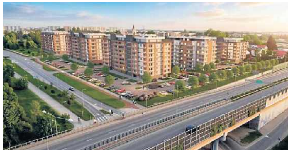
FOT.PROJEKT 2 QUADRA DEVELOPMENT
