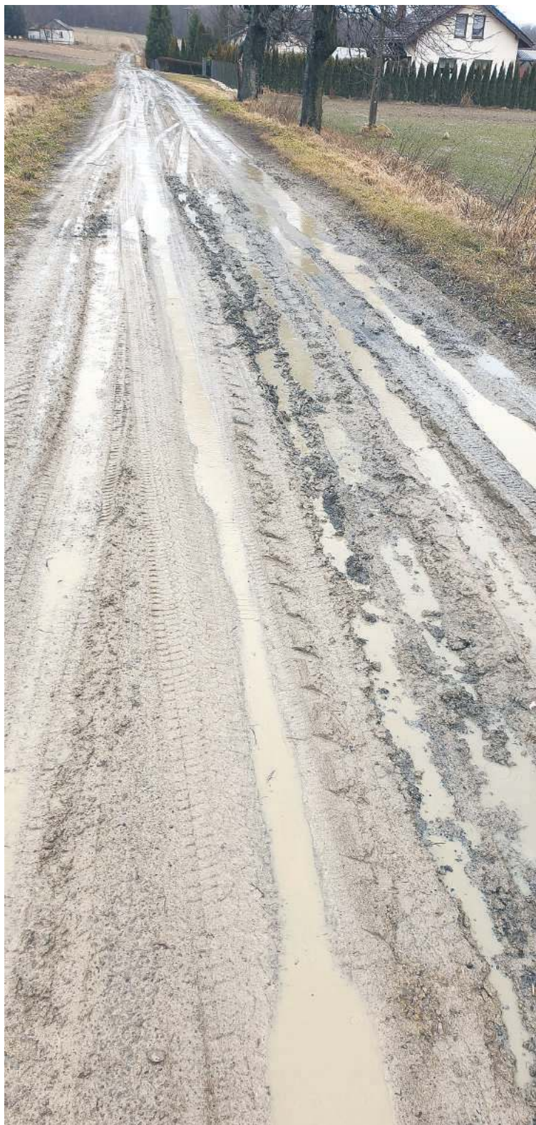
Droga w Wierzbicy (gm. Leśniewice) remontowana w ramach funduszu sołeckiego
