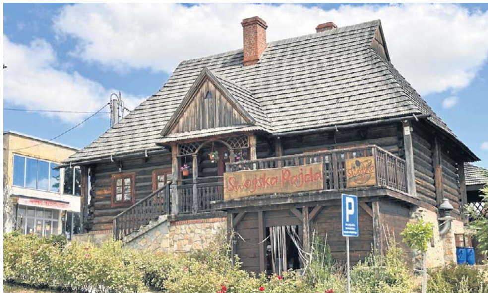
Przykład drewnianej zabudowy w Pruchniku
