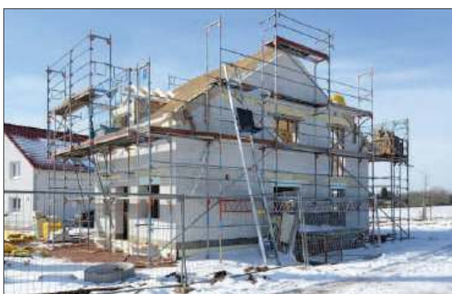
Z ulgi termomodernizacyjnej można skorzystać ze względu na zakup materiałów budowlanych potrzebnych do wykonania ocieplenia domu
