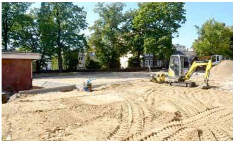
Rozpoczęły się prace przy budowie nowego boiska przy I LO.
