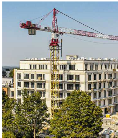
• Budowa domu w Zielonej Górze
