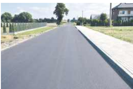
Przebudowana droga gminna w Fajstowicach
