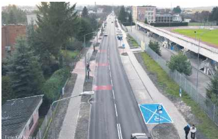
Przebudowa ulicy Piłsudskiego w mieście Krasnostaw
