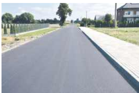
Przebudowana droga gminna w Fajstowicach
