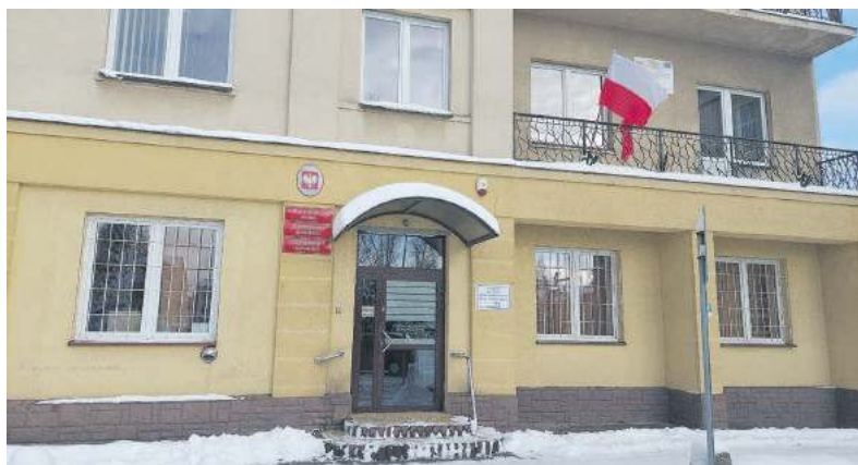
Rozbudowa planowana jest w połowie 2023 roku
