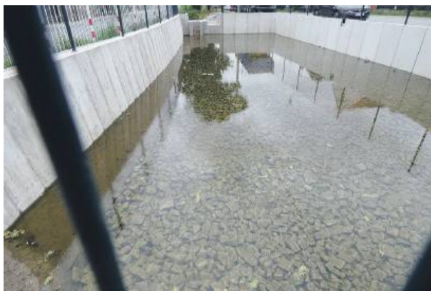
Dno zbiornika wyłożone jest granitowym kamieniem łupanym, frakcji większej niż tłuczeń
