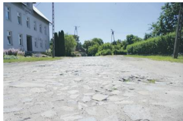
Nawierzchnia tej drogi zostanie zmieniona z kamiennej na asfaltową
