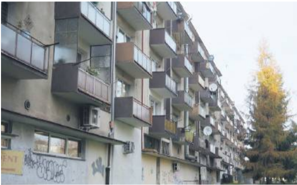
Spółdzielnia w Strzelinie przygotowuje się do remontu bloku w rynku
