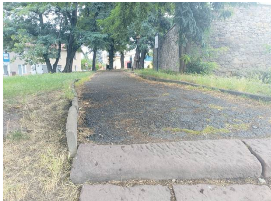
W ramach projektu zostanie zmodernizowany m.in. teren wokół dawnych murów miejskich przy ul. Pocztowej w Strzelinie
