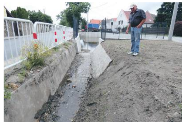
Rów i skarpa przed ujściem do osadnika
