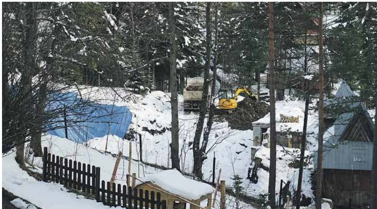
Na działce na Jaszczurówce trwa budowa trzech pensjonatów.
