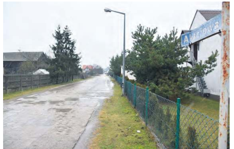
W Raciążu budowa dróg gminnych obejmie ulice: Akacjową, Jarzębinową, Modrzewiową i Topolową. Fot. Agata Wiśniewska
