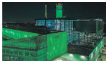
Warszawska Wytwórnia Energii, fot. Jan Zoll, projektant architektury FOROOM Sp. z o.o.
