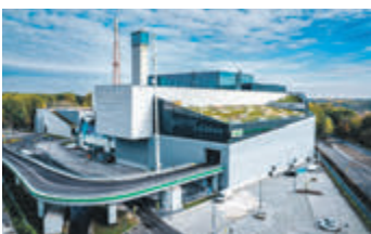
Warszawska Wytwórnia Energii, fot. Jan Zoll, projektant architektury FOROOM Sp. z o.o.
