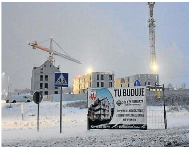
Budowa osiedla z trzema domami Społecznej Inicjatywy Mieszkaniowej w Malborku to koszt ponad 30 mln zł
