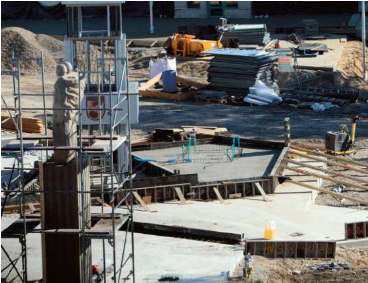
Mieszkańcy bloków stojących w pobliżu przebudowywanego placu Konstytucji 3 maja narzekają, że roboty budowlane prowadzone są również nocami
