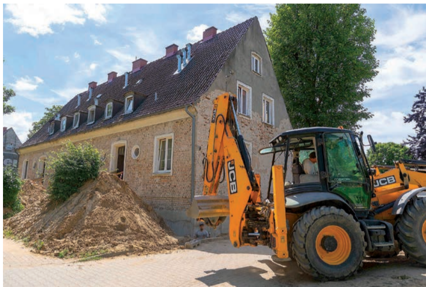
To pierwsze prace remontowe przy konstrukcjach (w tym fundamentach) zabytkowych bloków od dziesięcioleci.
