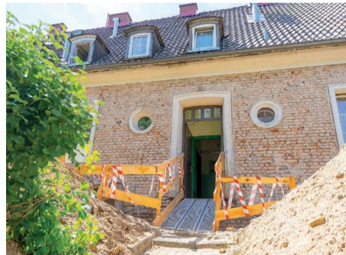
Na estetyczne zmieniają się wejścia i klatki schodowe.
