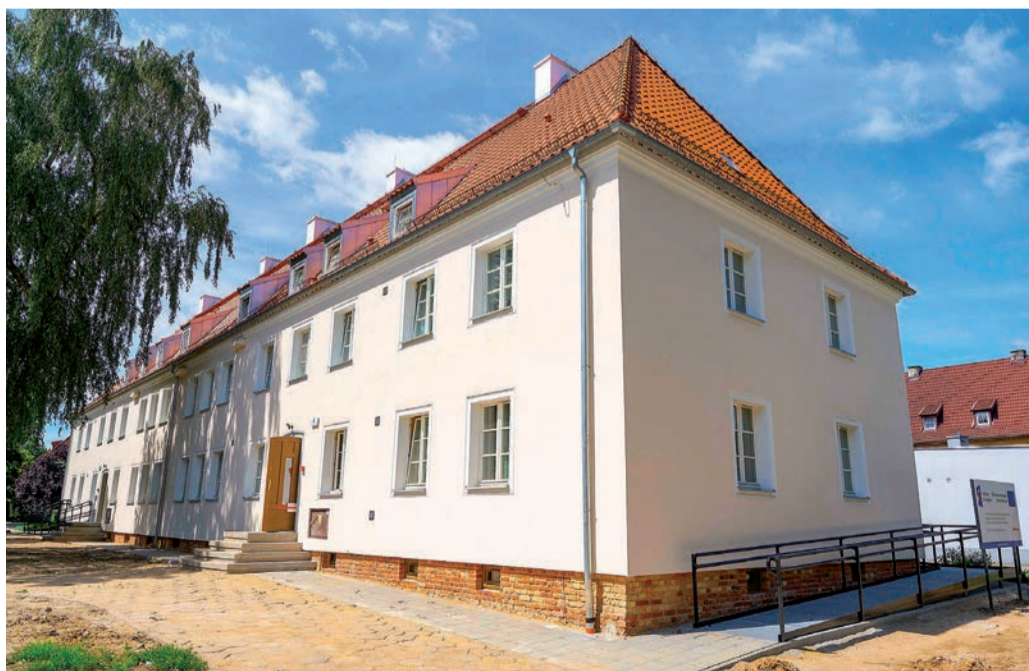
Cztery budynki termomodernizowane przy udziale środków unijnych są już prawie gotowe. Tak będą wyglądały pozostałe remontowane obiekty mieszkalne.
