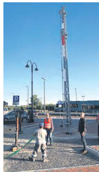
Semafor będzie spełniać rolę zabytkowego eksponatu przed budynkiem dworca.
