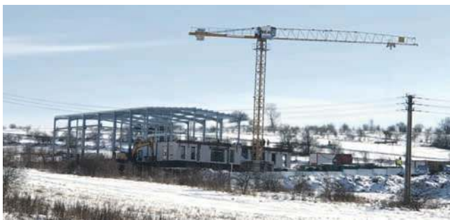
Powstaje siedziba firmy GeoFusion
