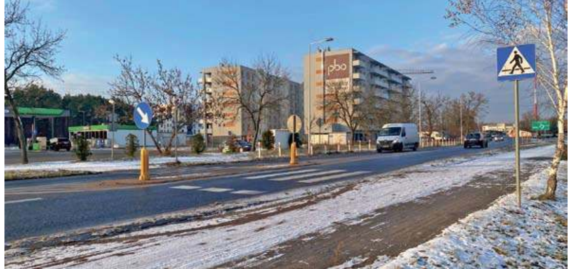
Na doświetlenie czeka m.in. to przejście przy ul. Zielonogórskiej
