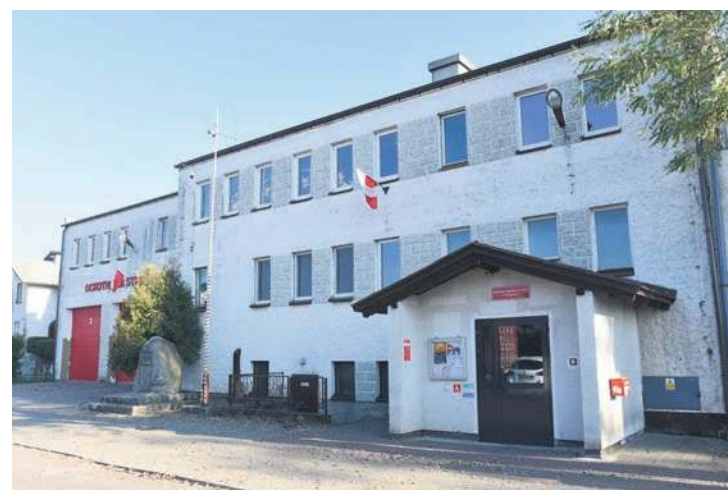
Jednym z zadań jest termomodernizacja budynków użyteczności publicznej.
