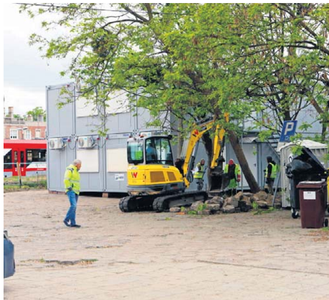
Tymczasowy dworzec budowany jest z 16 połączonych kontenerów. Będzie miał dwie kondygnacje
