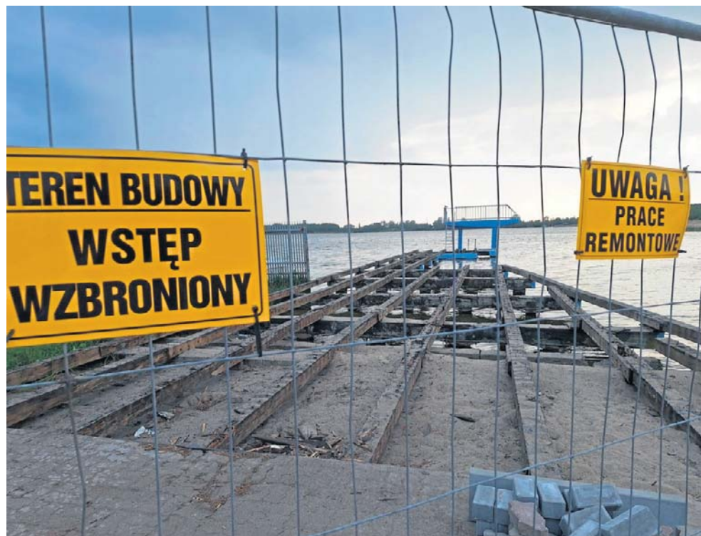
Trwa remont dużego pomostu na plaży miejskiej „Rudnik”
