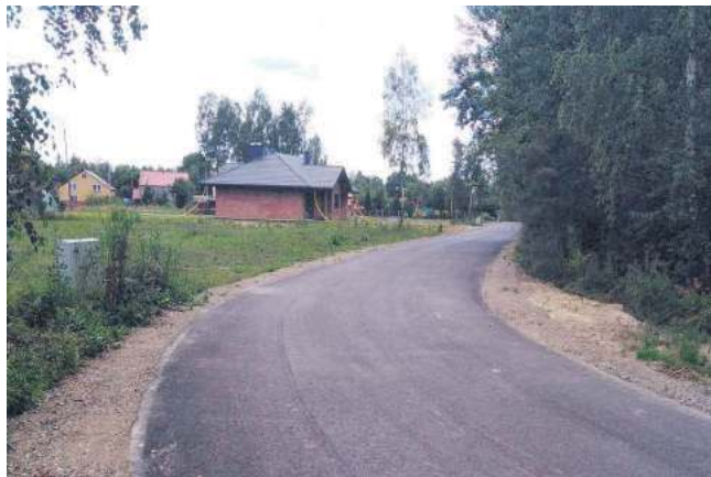
Przebudowana ul. Leśna we Frampolu.
