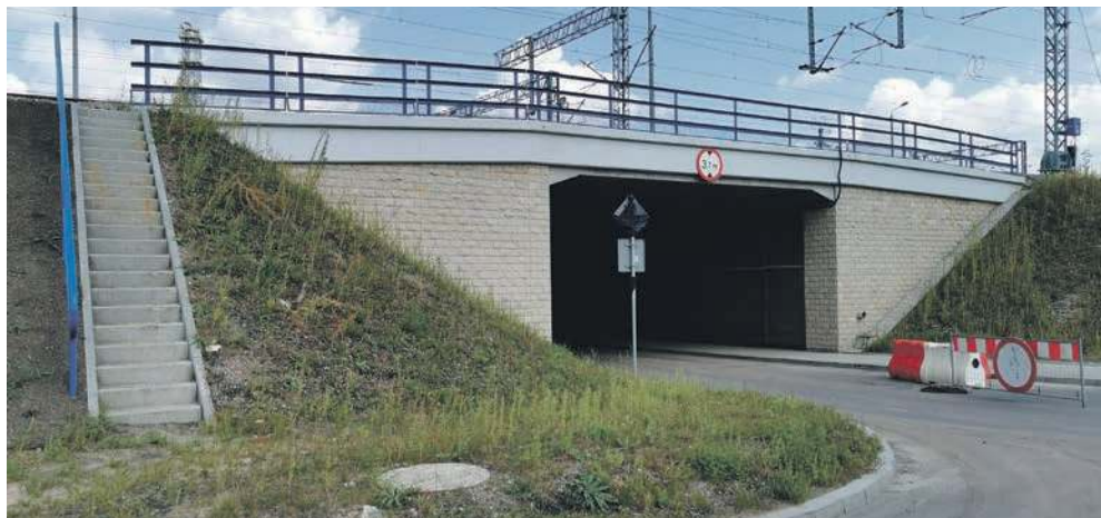
Wiadukt nad ul. Dworcową
