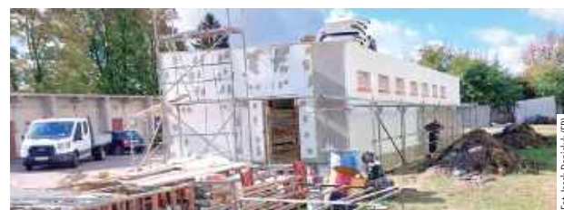
Prace przy modernizacji magazynu rwą do przodu, bo termin ich zakończenia krótki...
