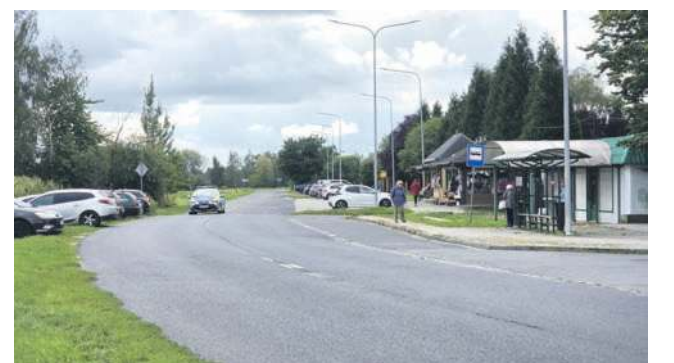
Do końca roku w okolicach nowego cmentarza w Oławie ma powstać zatoka i pętla autobusowa
