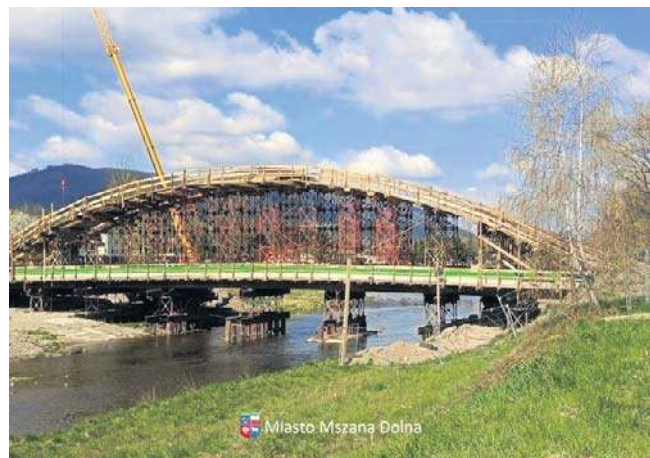
Trwają prace przy budowie ścieżki rowerowej i kładki nad Mszanką
