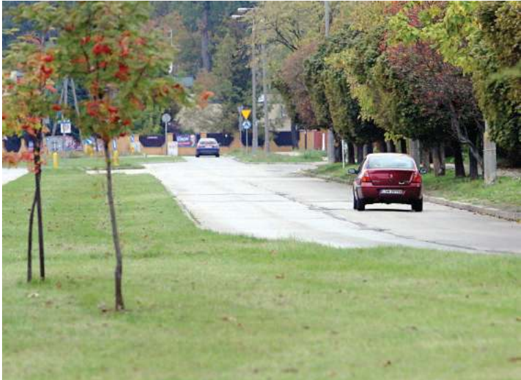
Nawierzchnia miejskiego odcinka ulicy Raławickiej zostanie naprawiona
