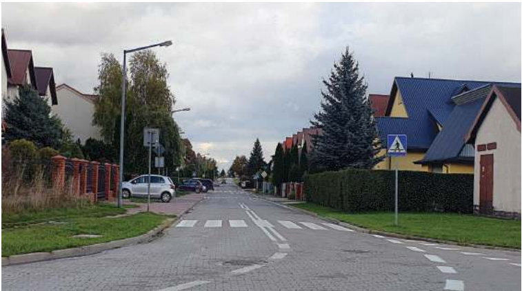
Absurdalna sytuacja z przejściami dla pieszych przy skrzyżowaniu ulic Czecha i Olimpijczyków w tym roku wreszcie zostanie rozwiązana
