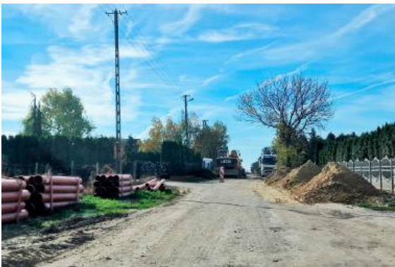
Patrząc na obecne zaawansowanie prac wielu mieszkańcom trudno uwierzyć, że do końca roku na ulicy Drewnianej pojawi się asfalt, chodniki i oświetlenie. Miasto zapewnia, że tak się stanie, bo drogowcy właśnie kończą najbardziej czasochłonny etap prac związany z budową infrastruktury podziemnej
