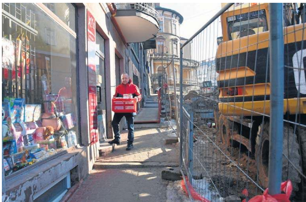
Poruszanie się rozkopaną ul. Batorego to nie lada wyzwanie. Na zdjęciu Antoni Nytko
