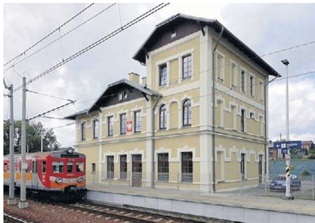
Planowany zakres prac obejmuje m.in. wykonanie klimatyzowanej poczekalni wraz z toaletami
