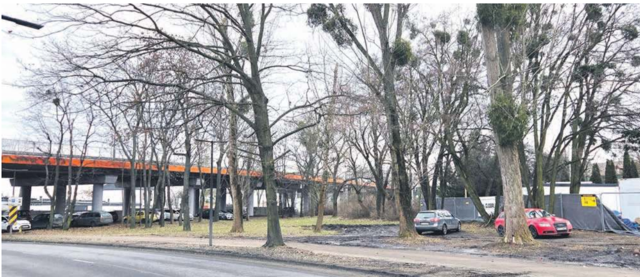
W tym miejscu przy ul. Spacerowej za 9 miesięcy powstanie parking
