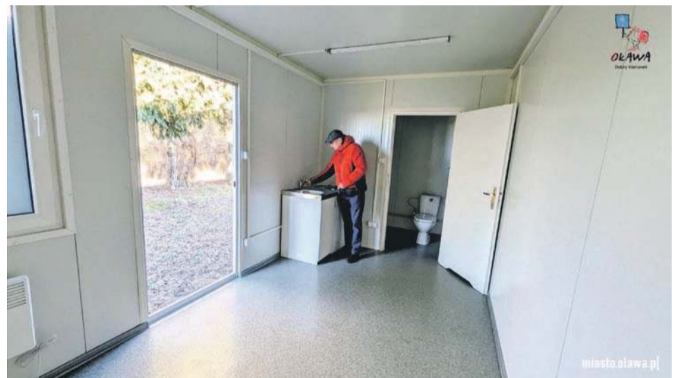
Kontenery mają węzeł sanitarny i ogrzewanie
