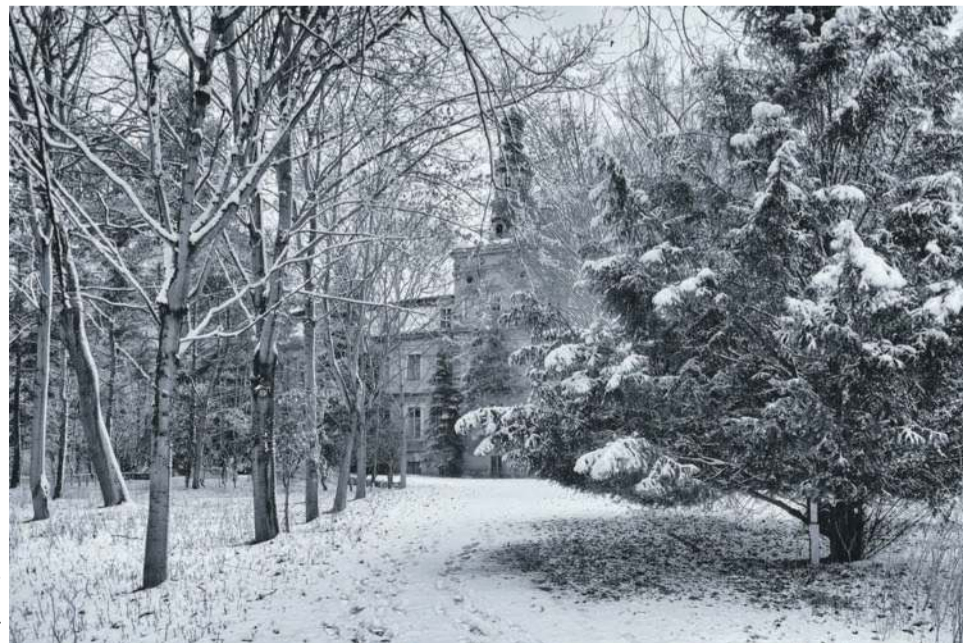
Neogotycki pałac wybudowany w latach 1886-1894 powstał w miejscu XVII-wiecznego drewnianego pałacyku myśliwskiego. Należał do rodziny Saurmów, o czym zaświadcza rodzinny herb na frontonie
